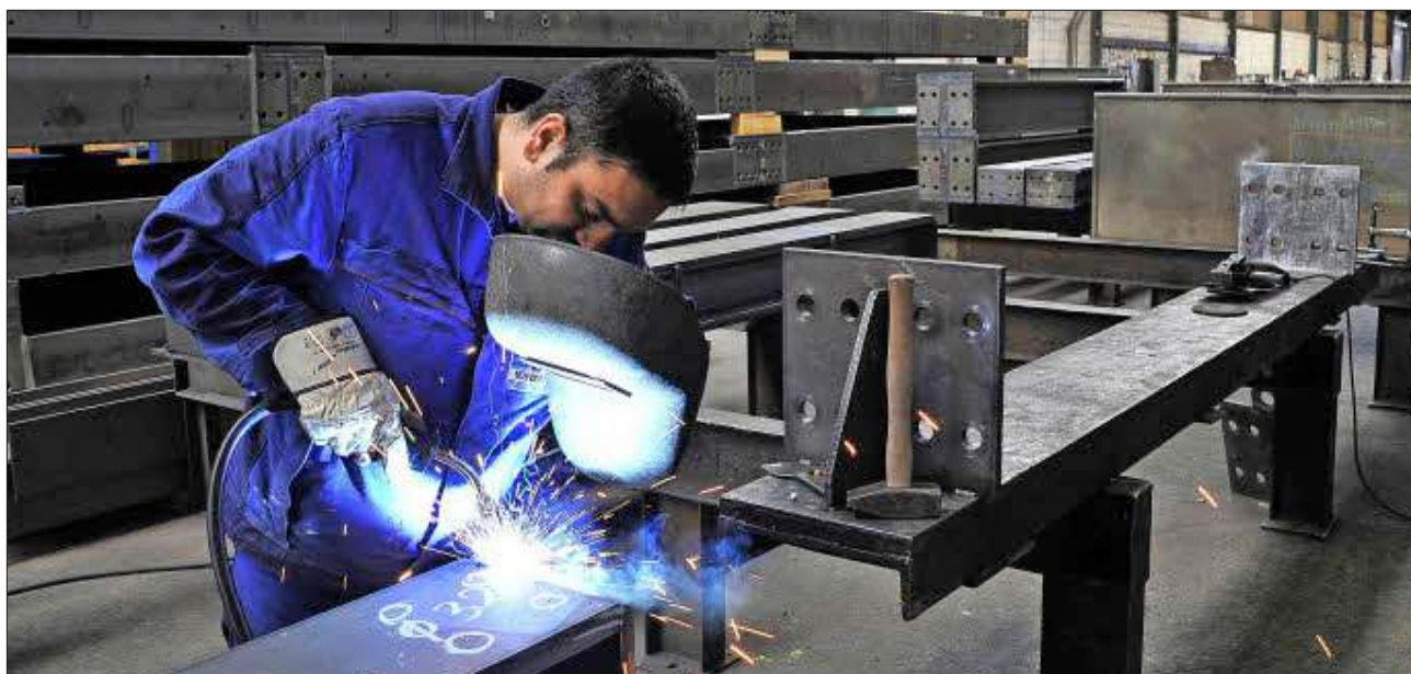
Anlagenbau bei Schauenberg in Kirchzarten
